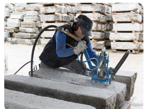
Gehamerde afwerking van boordstenen © Steengroeve Bonneuil-sur-Marne
