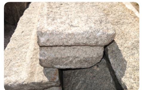
Boordstenen met tand-en-groefstelsel (graniet)
