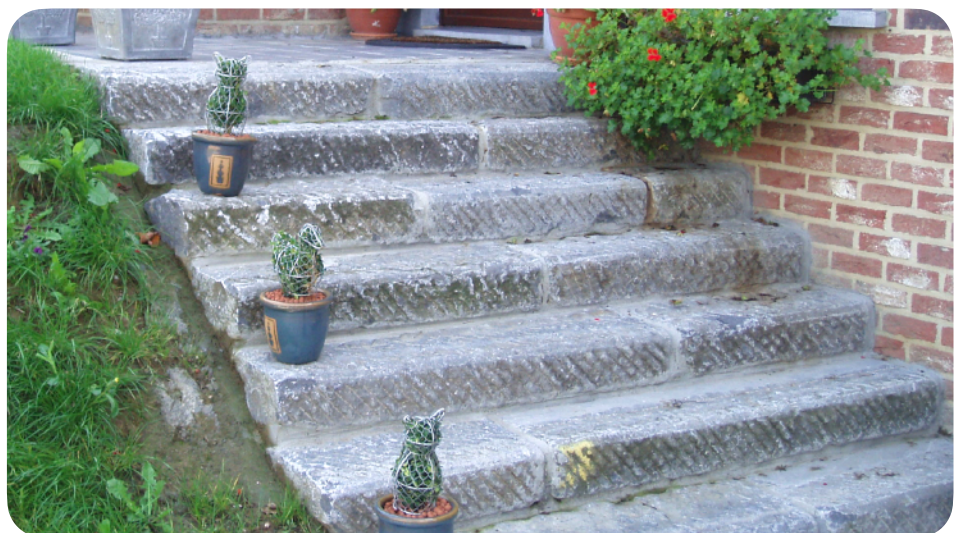
Hergebruik van boordstenen als traptreden (FR) © Noblema
