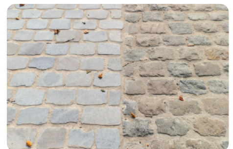
Aanbrengen van gezaagde / ruwe bestrating
