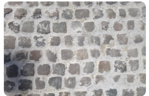
Kasseien gevoegd met cement: de recuperatie zal een stuk moeilijker zijn.
