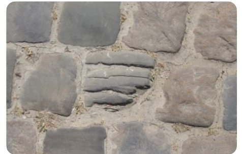
Voorbeeld van slecht geplaatste kassei in grès. Het laagvlak moet evenwijdig zijn aan de legrichting. Wanneer dat niet het geval is zal de kassei veel sneller barsten of breken onder belasting. Deze kassei zal tijdens de sortering weggegooid worden.
