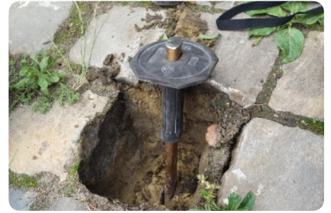
Kasseien in grès gelegd volgens de traditionele manier op een zandbed: de recuperatie zal over het algemeen gemakkelijk verlopen.
