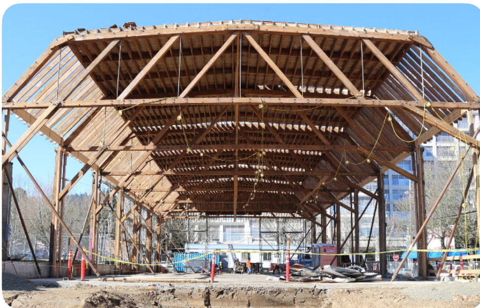
Hergebruik van 2 000 lopende meter houtmassiefbouwelementen. Redfox Commons (2019) (USA) © Leverarchitecture.com
