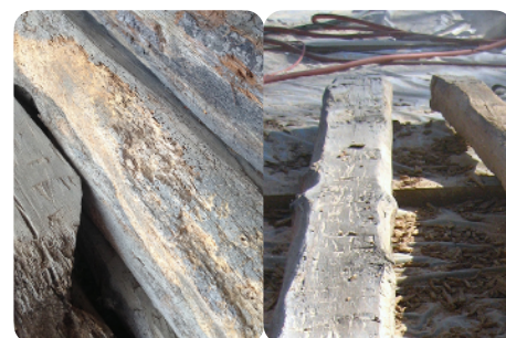
Verwijderen van schors, spinthout en houtspanen © yr-architecture
