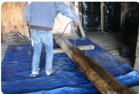
Afwerkingsbehandeling van het hout © yr-architecture
