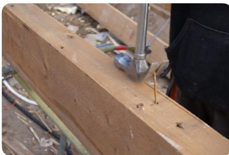
Verwijderen van metalen elementen
