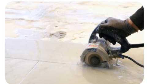
Doorzagen van de voegen
